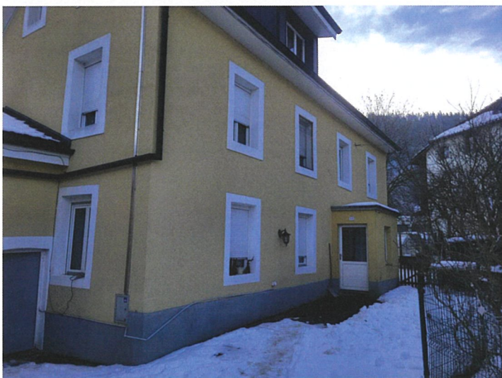
Accès, entrée principale
