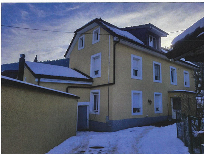
Accès, angle Nord-Ouest
